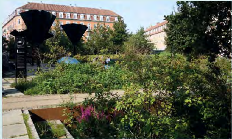
I förgrunden en av de nedsänkta regnbäddarna och längre bort syns regnparasollerna och vattendropparna som både fungerar som vattenmagasin och skulpturer. FOTO: NINA NORDH
